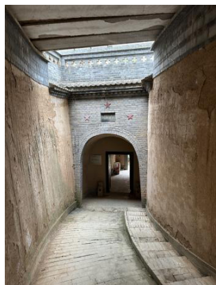
图 2 地坑院窑洞入口
