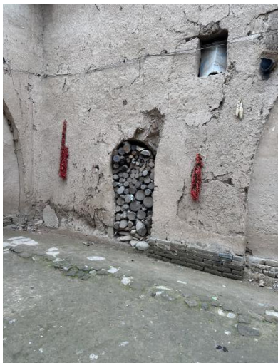
图3 窑脸的脱落
