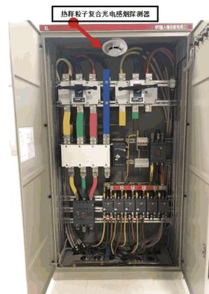
图8 热释粒子复合光电感烟探测器监控区域
