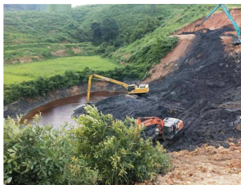
图1 鱼洞煤矿矿山地质环境治理工程
