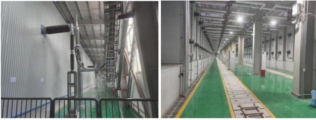
图 3 110kV 直入式蓄热电锅炉
