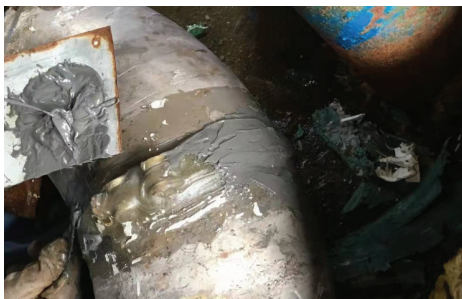
图2 天然气管道修复图
