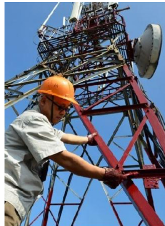
图 3 通信铁塔防腐处理现场图
