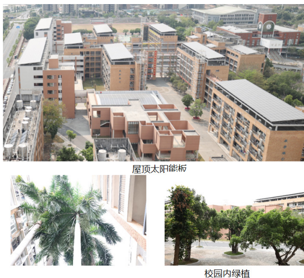
图 26 节能二星、屋面安装光伏新能源节能板
