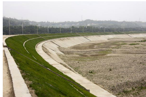
图 5 江户川堤防工程
