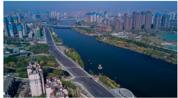
图 4 海河整治工程
