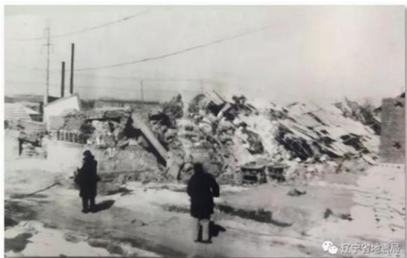
图 16 营口市百货公司仓库倒塌现场
