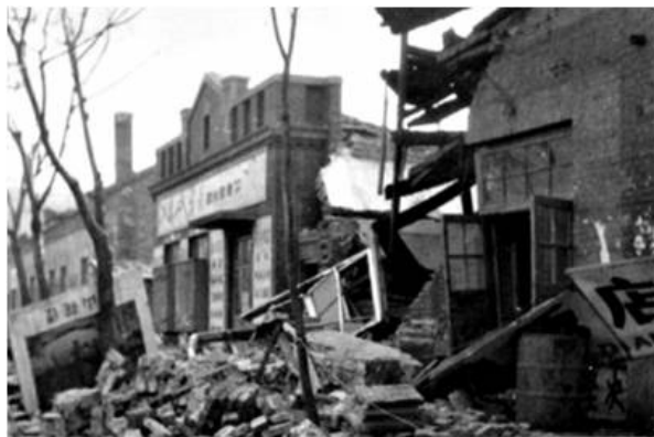
图 17 营口市西市区站前饭店倒塌现场
