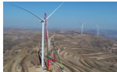
图 1 铁厂坝风电工程
