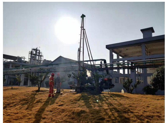
图 2 某工业园区治理地下水污染现场
