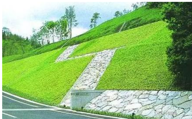
图1 某高速边坡绿化
