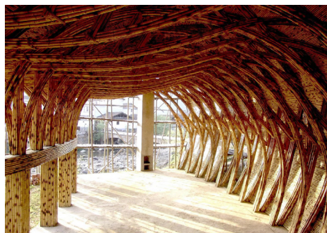
图2 接待中心的弧形墙体及屋顶
