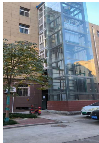
图 5 美化公共楼道墙面、加装电梯
