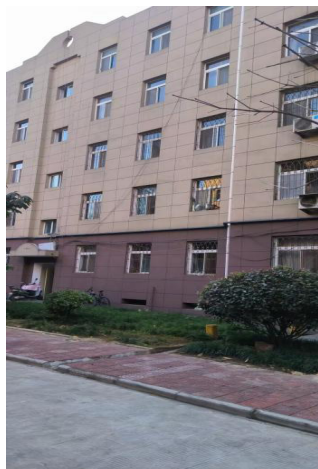
图 4 屋面防水、铺设外墙保温
