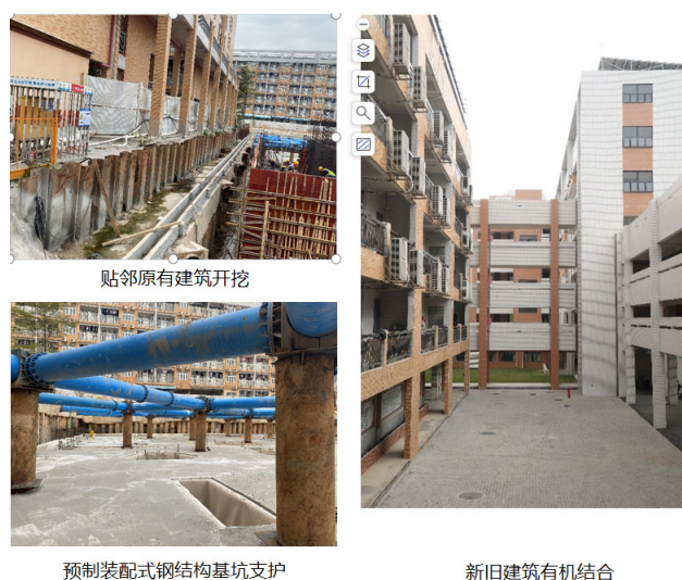
图 25 先进性的预制装配式基坑支护设计
