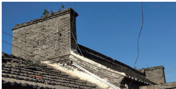
图9 伍佑镇东包厂172号的一阶屏风墙
