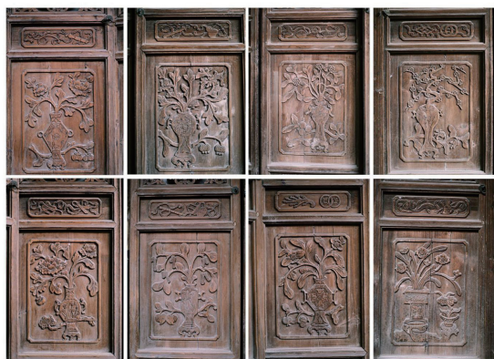
图12 鲍氏大楼东侧小院隔扇门镶板
