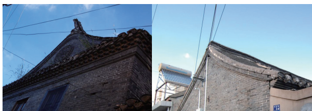
左图：图10 曾氏大楼水磨砖细包镶博缝
