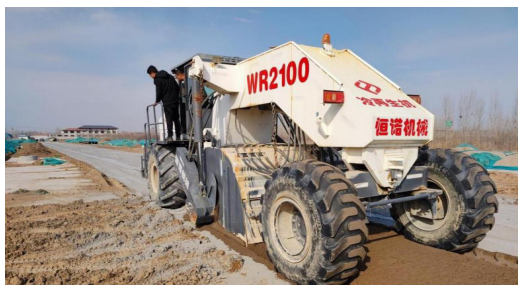
图5 冷再生机搅拌土料
