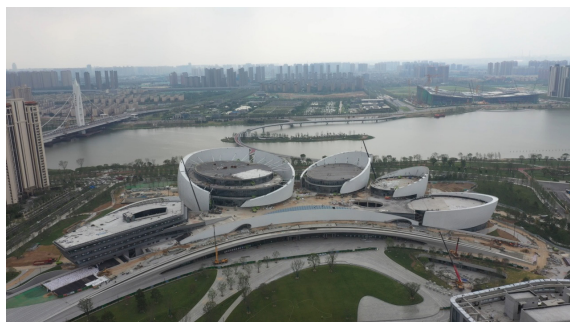
图1 “长安乐”项目大面封闭后实景图
