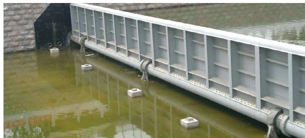
图 2 钢坝闸结构(工程实例照片)
