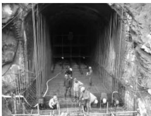
图 1 涵洞口施工图
