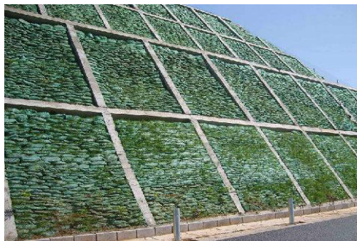
图 1 三维植被网护坡示意图
