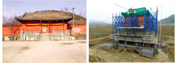
图1 遇真宫原址影像图(左)和遇真宫整体顶升施工影像图(右) [30]
