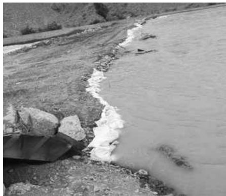
自溃式溢流堰现场图
