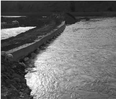
分水口涵管引水现场图
