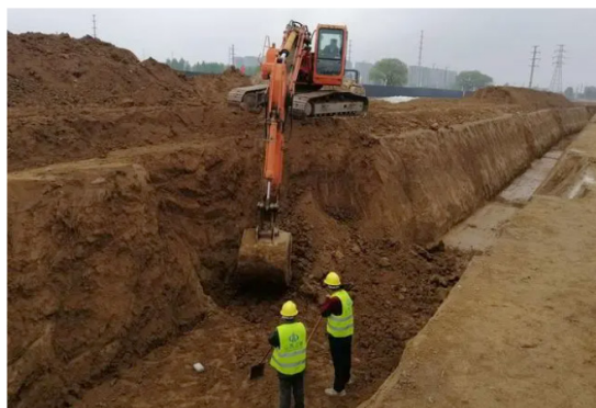
图 1 挖槽施工
