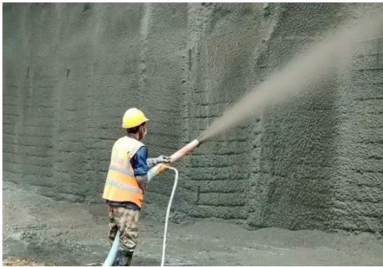
图3 喷射混凝土施工
