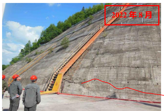
图 5 小山电站厂房后山坡
