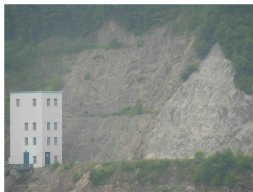
图 7 引水隧洞进口边坡（全景）
