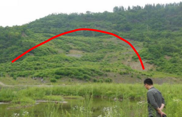
图 9 大坝右岸坝下滑坡（HL01）（2015）
