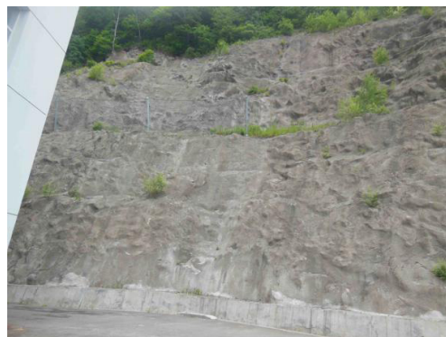
图 8 引水隧洞进口边坡（近景）
