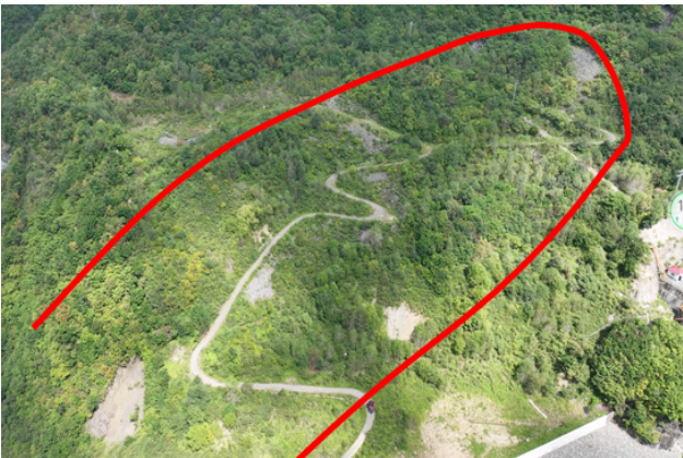
图 10 大坝右岸坝下滑坡全貌（2022）
