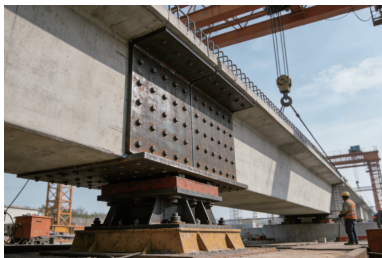
图1 梁底预埋钢板与支垫石结合图
