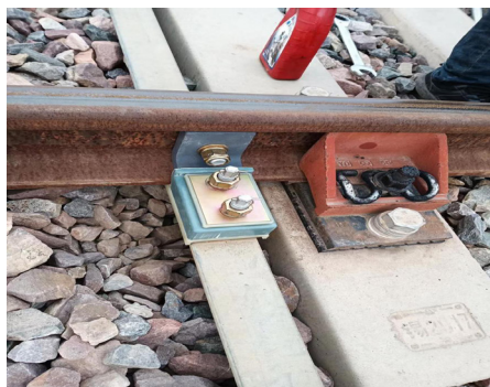
图6 整体绝缘角形铁的安装
