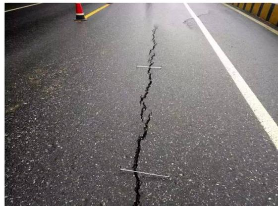
图1 公路路基路面裂缝病害
